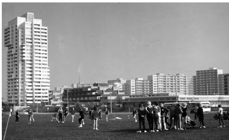
Wohnsiedlung der Neuen Heimat in Kiel-Mettenhof.
